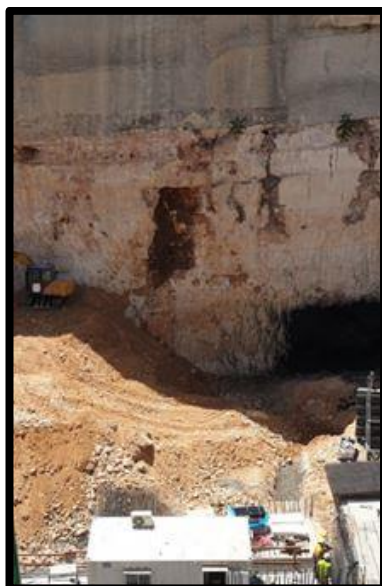
קיר אלמנטים. ניתן לראות כיצד נראים חללי קארסט מלאים אדמת חרסית אך יתכן ממש חלל-מערה.
