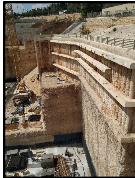
קיר דיפון מכלונסאות קלאסי בחלק העליון בלבד (משאירים בתחתיתו מדרגה קטנה החלק התחתון חצוב או מנוסר עם ברגים בלבד)
