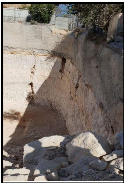
קיר אלמנטים עם שתי רשתות ברזל קלאסי בחלק העליון מעוגן במסמרים המכוסים בבטון התזה החלק התחתון מנוסר ללא תמיכה. הקבלן מנסר גושי סלע ומוכר לשיש.
