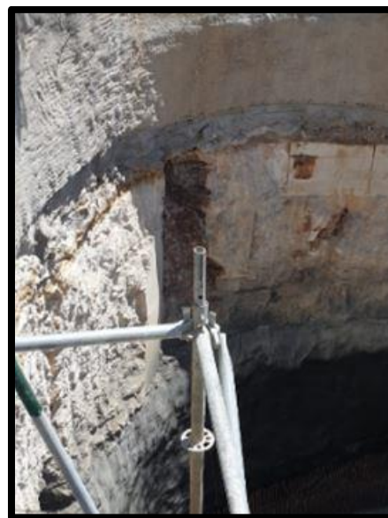
קיר אלמנטים. ניתן לראות כיצד נראים חללי קארסט מלאים אדמת חרסית אך יתכן ממש חלל-מערה.
