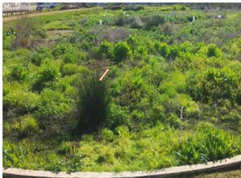
תמונה 1: אגן מספר 1 בתוך קומפלקס אגנים ירוקים בהוד השרון, המשמש לניקוי שלישוני של מי קולחים בטיפול ביולוגי, שבו משתמשים במיקרואורגניזמים ובצמחים הגדלים על מצע חצץ. במרכז נמצא צמח סמר חד, אחד הצמחים שנבחנו בעבודה זו, מסומן בחץ.
