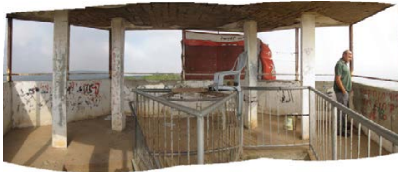
מרכסות התצפית במעלה המגדל, חלונות חסרים, תקרה מתפוררת, גרפיטי והזנחה
