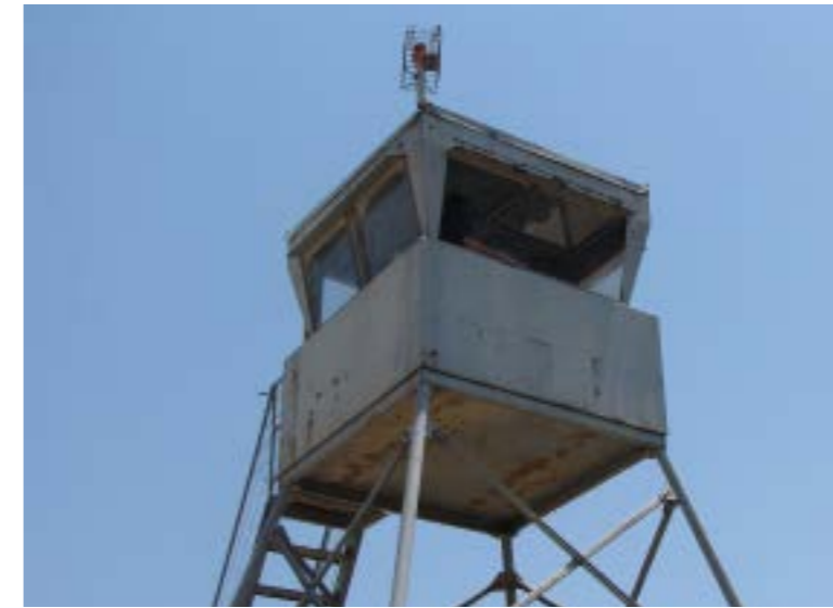
חלקו החיצוני של תא התצפיתן- ישן ומלא בחלודה
