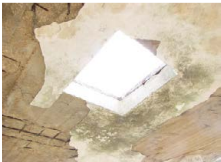
התקלפות טיח מהתקרה וחשיפת ברזלי הזיון, סכנה של נפילת חלקי בנין על מבקרים.
