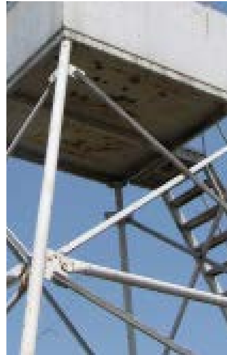
חלודה וקילוף צבע בתחתית תא התצפיתן
