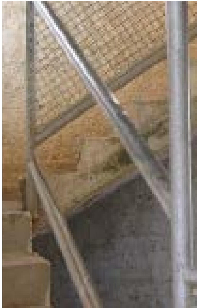
פרט חיבור מעקה למדרגה. המעקה מורכב ממאחז עליון, מאחז תחתון וביניהם רשת. במקומות מסוימים הרשת כבר אינה קיימת ועל כן העלייה למגדל מסוכנת
