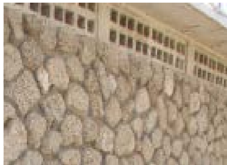
חיפוי המגדל באבן פראית ופתחי איורור ודקורציה מבטון ושפריץ
