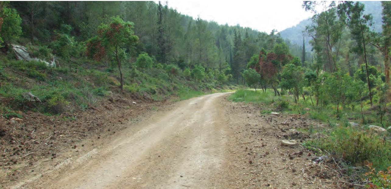
תמונה 13. גיזום, ריסוק וכיסוח צומח בצידי הדרך. ניתן להבחין כי בוצעו כריתת עצי המחט הצמודים לדרך, גיזום עצי החורש, ריסוק גזם וכיסוח הצומח העשבוני. נחל כיסלון, 2019. צילום: חנוך צורף
