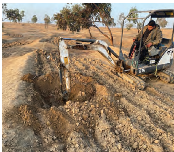
תמונה 21: אופן הכנת השטח - פתיחת בורות נטיעה עם מחפר בשטח עם קציר נגר על ידי שיחים. נגב מערבי.
