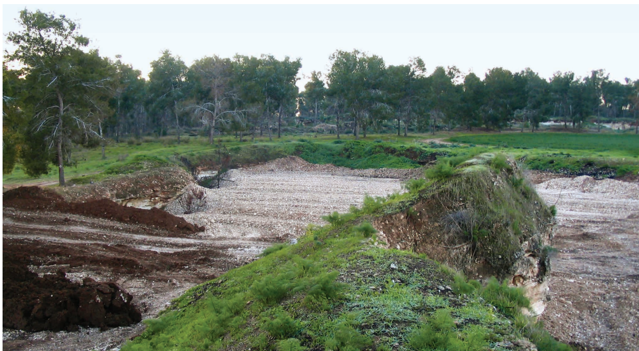
חיפוי הגבעה בשכבת קרקע עליונה שנאספה מתוואי הכביש. מבט לכיוון דרום, 2005 צילום: גיל סיאקי
