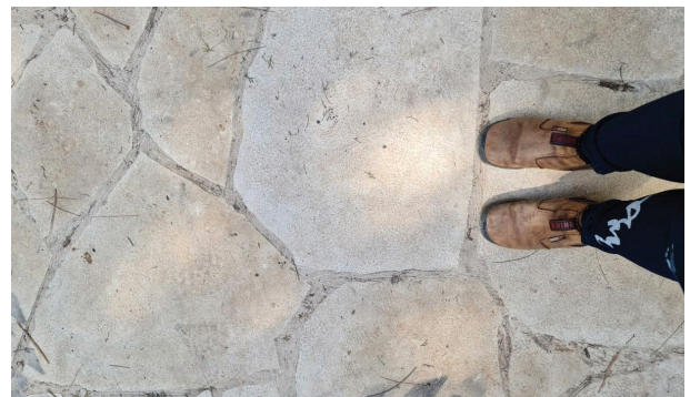
ריצוף אבן שעוצב לנושא ההנגשה בפרויקט נחל השופט: אבן טבעית בעיבוד מוטבה מנוסרת בצורה פראית עם כוחלה מינימלי בגובה האבן לקבלת מרב המשטח מיושר וללא בליטות צילום: בלה נודלמן
