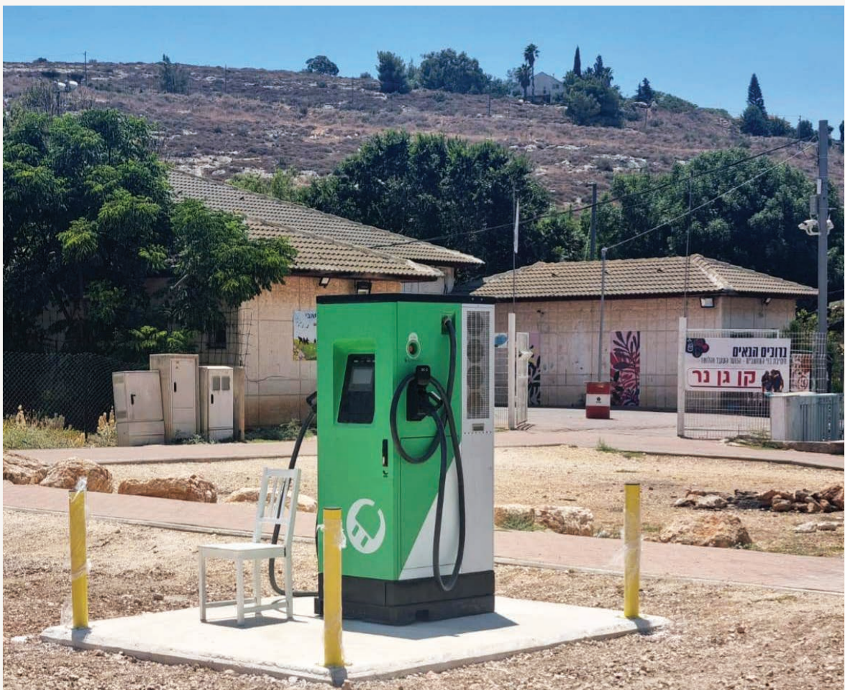
עמדת הטעינה החשמלית של האוטובוסים. תמונה: המועצה האזורית גלבע
