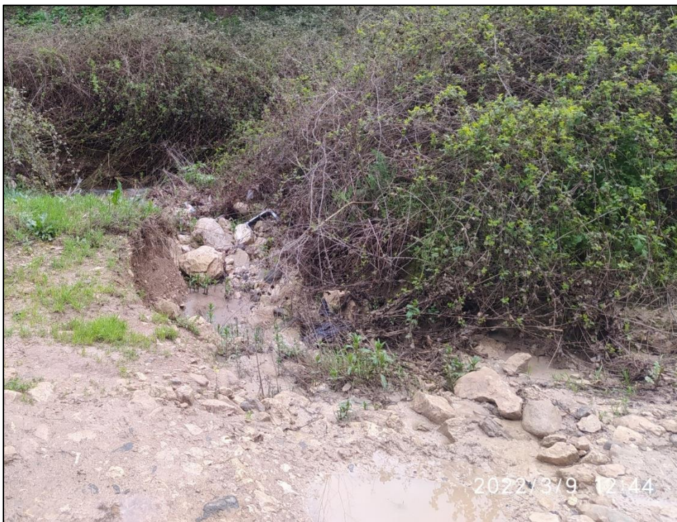
תמונה 27: התחתרות בדרך התפעולית בגדה השמאלית של מקטע 4. הזרימה השיטפנית זרמה על גבי הדרך העוברת בתוך פשט ההצפה. בנקודה זו היתה חזרה של מים מהפשט לאפיק.
