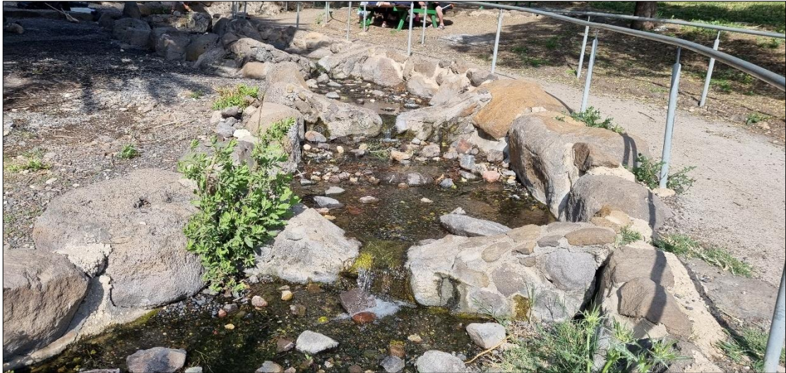
תמונה 7: קטע מהערוץ המלאכותי דרכו זורמים המים מהנביעה הראשית למורד לאורך סדרה של מפלונים קטנים. רוחב האפיק הרטוב בערוץ כ-1.6 מ' ועומק המים 10-12 ס"מ. התשתית מבטון ועליו חצץ, אבנים קטנות וסלעים מטובעים מאבן בזלת (12.04.22, צילם: אלדד אלרון).
